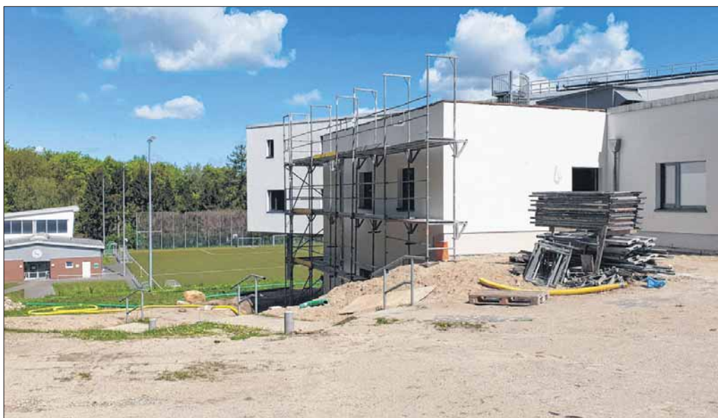
Das Gerüst verschwindet. Mit der fertiggestellten Fassade wird auch das Baugerüst am neuen Wirtschaftstrakt nicht mehr benötigt.
