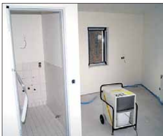
Trocknungsgeräte in dem Zimmern sorgen für das Abtrocknen des Estrichs.
