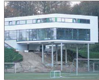
Das äußere Erscheinungsbild des Uwe Seeler Fußball Parks nimmt Formen an.
