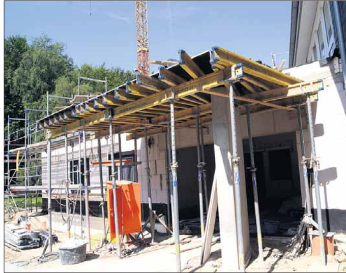
Der neue Haupteingang im Rohbau.
