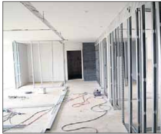
Im alten Schulungsraum im ersten Obergeschoss entstehen neue Übernachtungszimmer.
