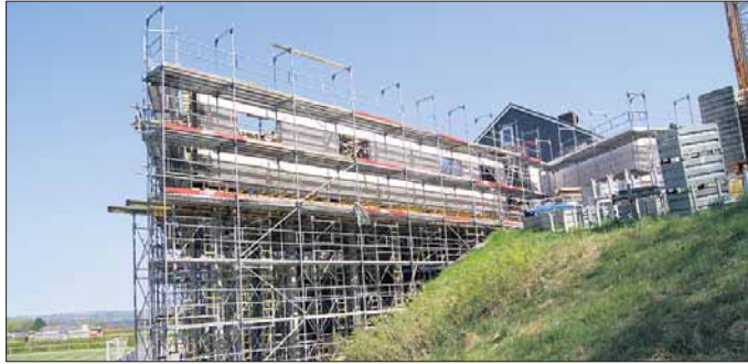
Seitenansicht des Neubaus zum Hans-Hermann-Sütel-Platz (Kunstrasenplatz): Das neue Gesicht der Sportschule schimmert schon durch.
