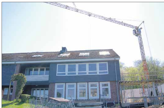
Hier grenzt der alte Gebäudebestand an den Neubau.
