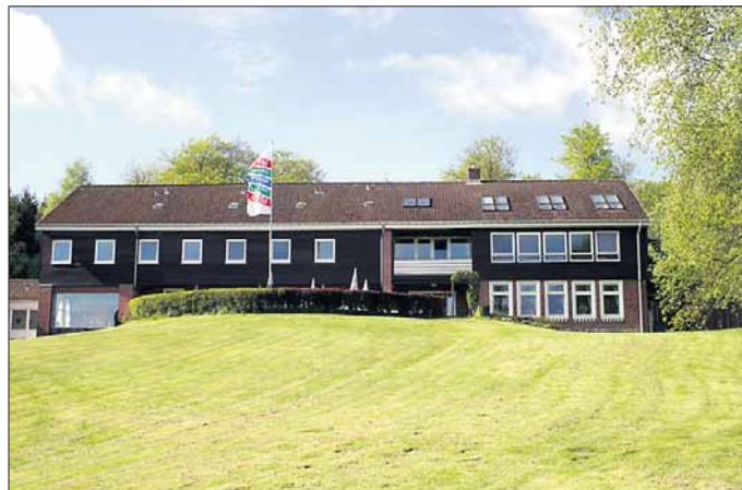
Unter Beibehaltung des traditionellen Ursprungsgebäudes wird in diesem Jahr das Hauptgebäude der Sportschule saniert.
