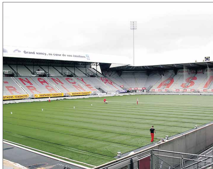
Nach dem Einbau der Elastikschicht wird der Polytan LigaTurf RS+ in Nancy verlegt.
