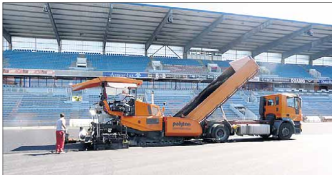
In Lorient wird die Polytan-Elastikschicht eingebaut.
